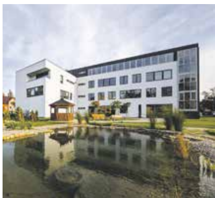
Nová nízkoenergetická budova
